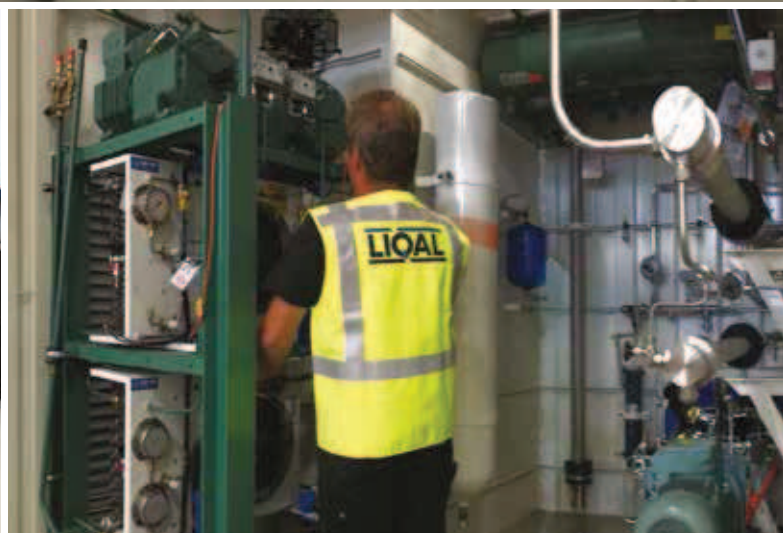
De Micro liquefaction unit zit in een 10-voets container. Deze staat op het station in Alkmaar.
